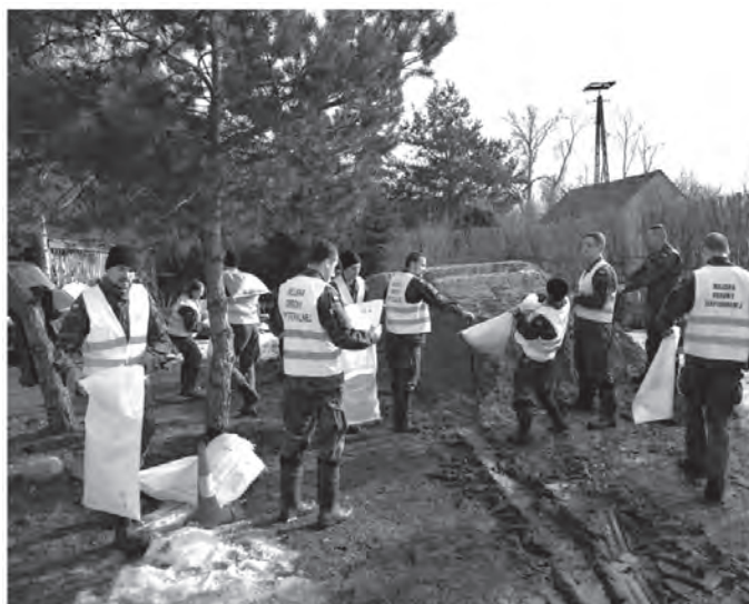
Rysunek 9. Żołnierze WOT pracują przy wzmacnianiu wałów przeciwpowodziowych w ramach WZZ Płock w miejscowości Wyszogród
